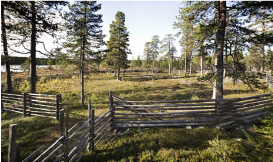
Rengärde i Sundtjärn, Malå kommun. Den består av 5–7 på varandra lagda stockar. Gärdet är 60 meter i diameter.
