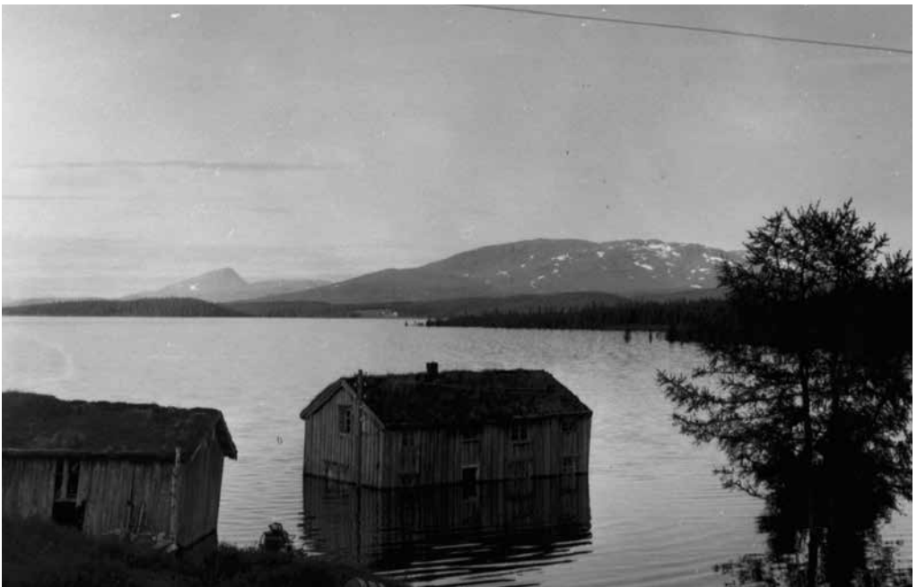
Oppdemming av Røssvatnet.
