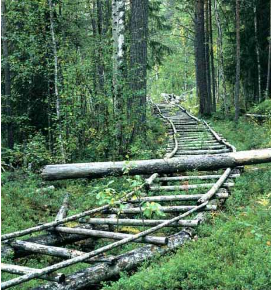
Flottarbanan vid Gargån i Sorsele kommun. Den användes för att dra båtar förbi Trollforsen.
