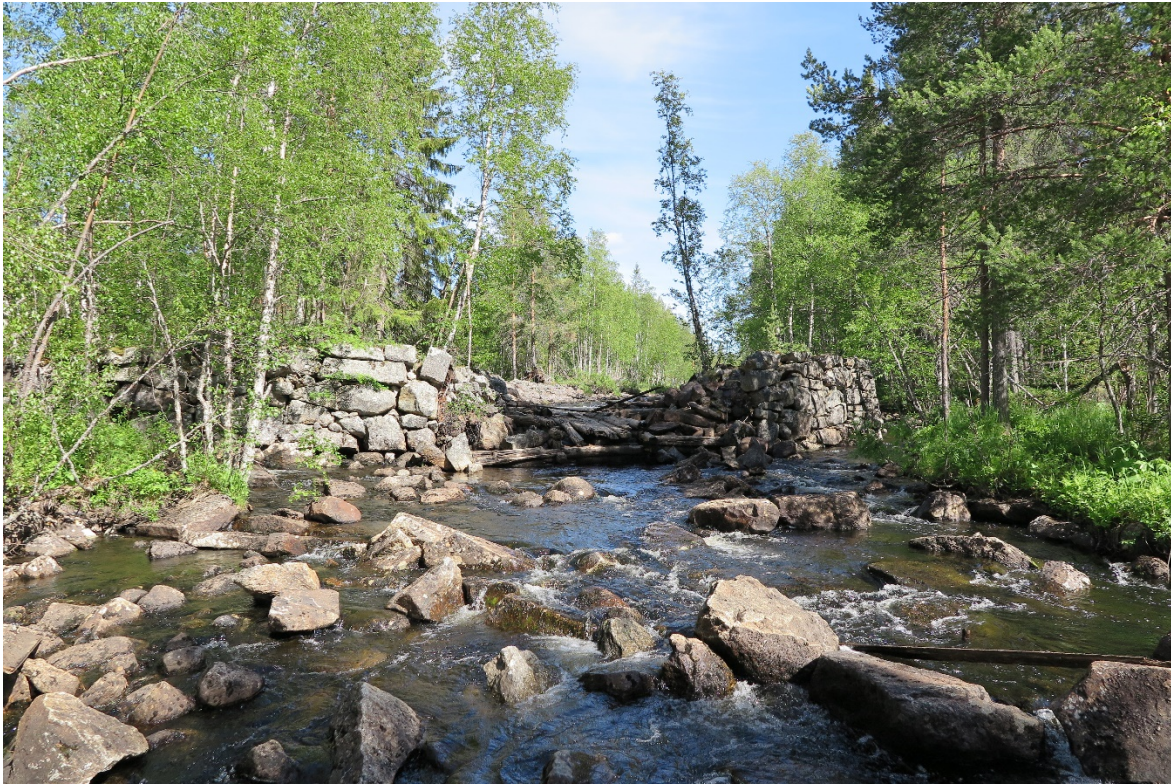
Flottningsdamm av huggen sten i Laisbäck, Storumans kommun.
