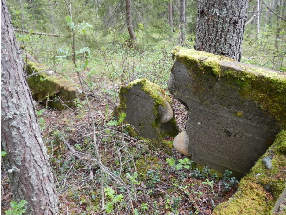
Gjuten husgrund av cement. Då cement var dyrt blandade man in stenar i grunden.
