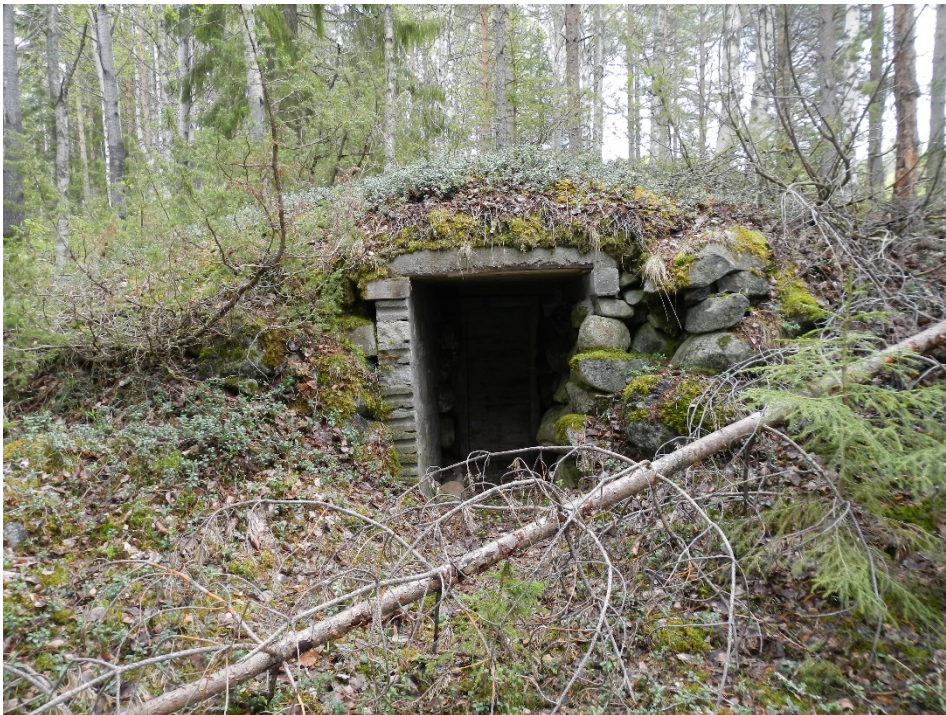
Jordkällare av natursten och cement.
