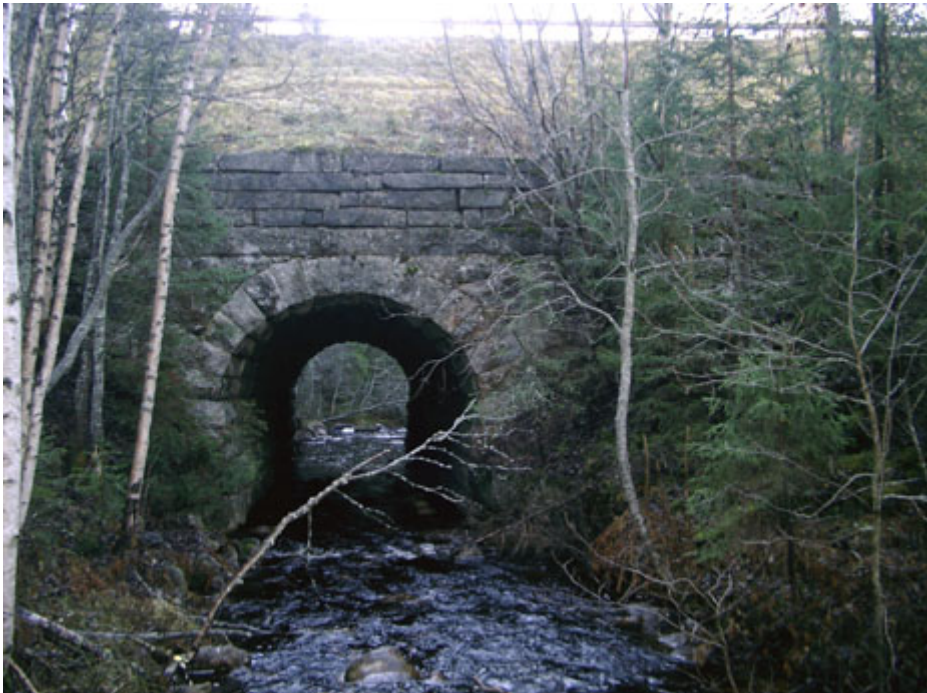
Stenvalvsbro över Gravån, väg 651 i Botsmark, Umeå kommun.
