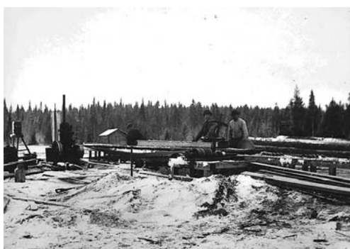
Exempel på sågning vid ett mindre sågverk. Detta drivs med en råoljemotor. Ångdrivna sågverk eldades med ved, kol eller koks. Foto: Västerbottens Museums arkiv.
