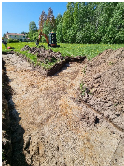
Figur 18. Schakt 4 och 7 med A1, ett dike.
