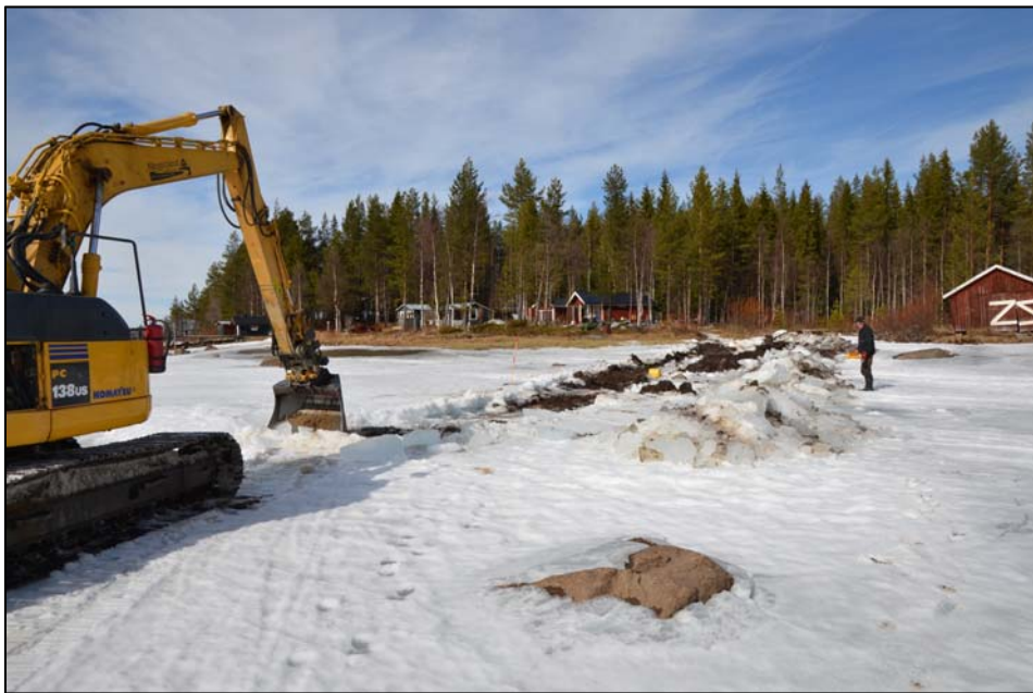
Fig. 6. Avbaning och grävning av ledningsschakt vid Maksjön. Foto mot N.
