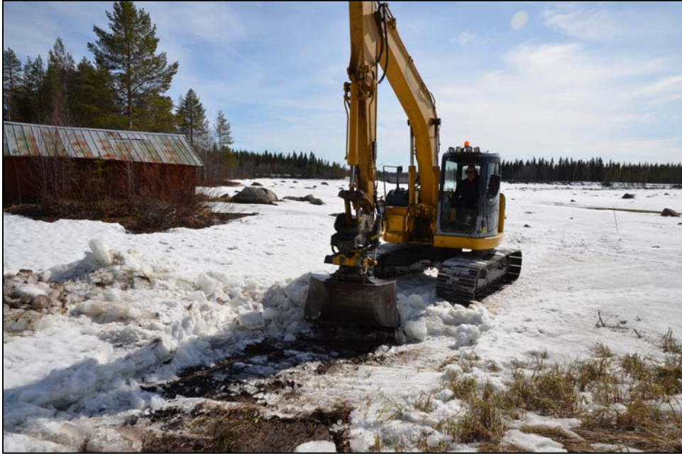
Fig. 5. Avbaning och grävning av ledningsschakt vid Maksjön. Foto mot S.
