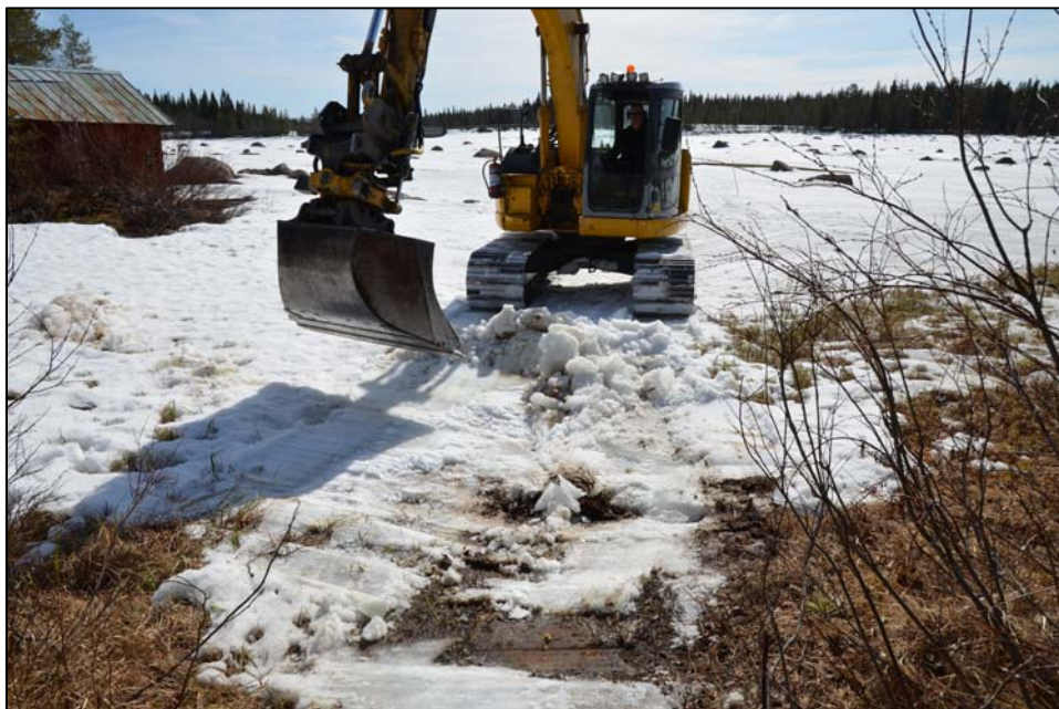
Fig. 4. Avbaning och grävning av ledningsschakt vid Maksjön. Foto mot S.
