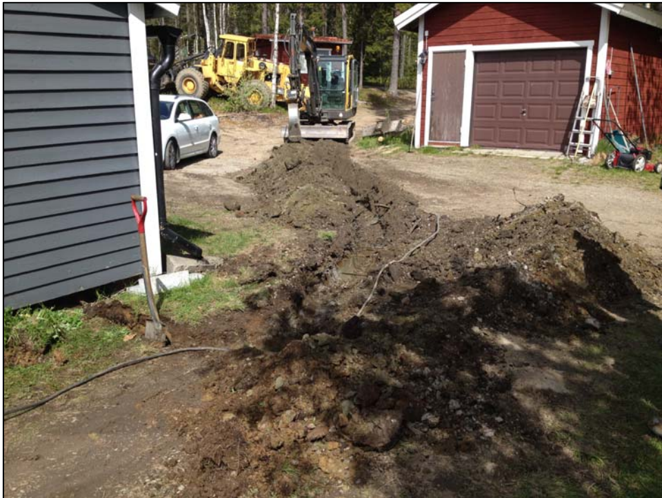
Fig. 8. Avbaning och grävning av ledningsschakt vid Maksjön. Foto mot N.
