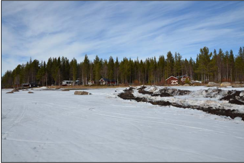
Fig. 7. Avbaning och grävning av ledningsschakt vid Maksjön. Foto mot N.
