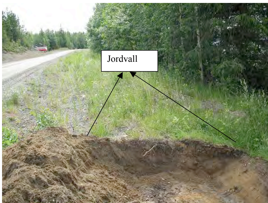
Fig. 12. Jordvall med fyllnadsmassor i anslutning till vägen, här i områdets östligaste del.
