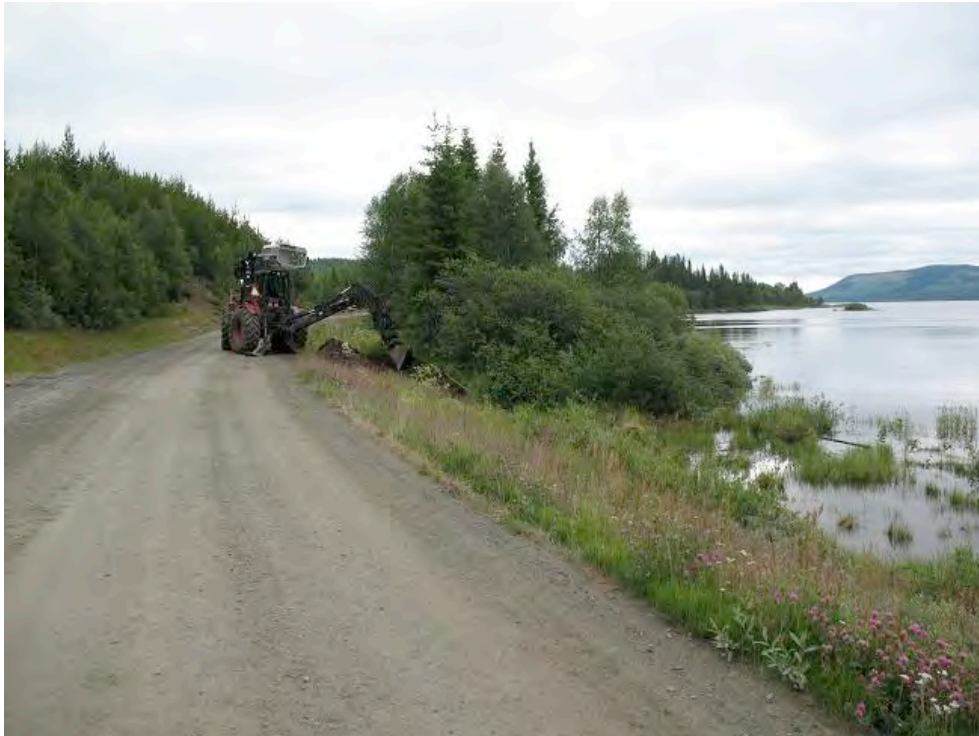
Fig. 10. Den västligaste delen av det schaktkontrollerade området i Norra Tresund.
