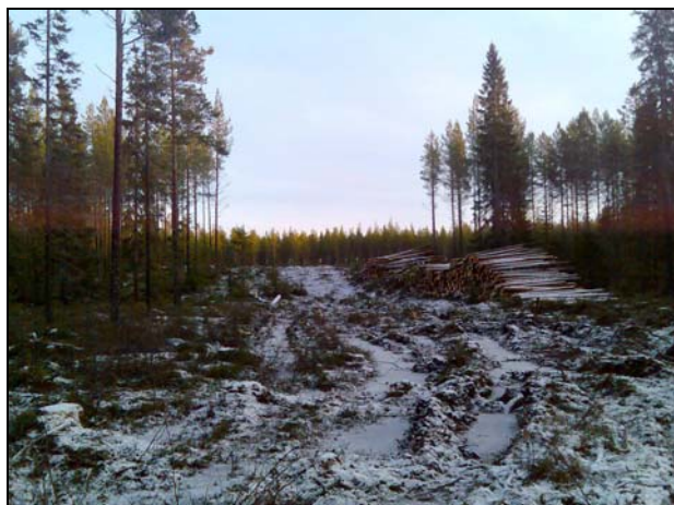
Anslutningsväg till vindkraftverk 3
