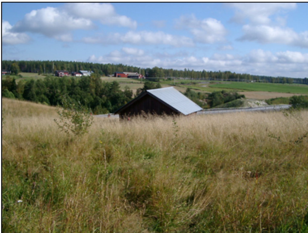
Fig 2: Den nya vägen kommer att gå uppför branten, genom ladan. Europaväg 12:s övergång över Idebäcken i bakgrunden.
